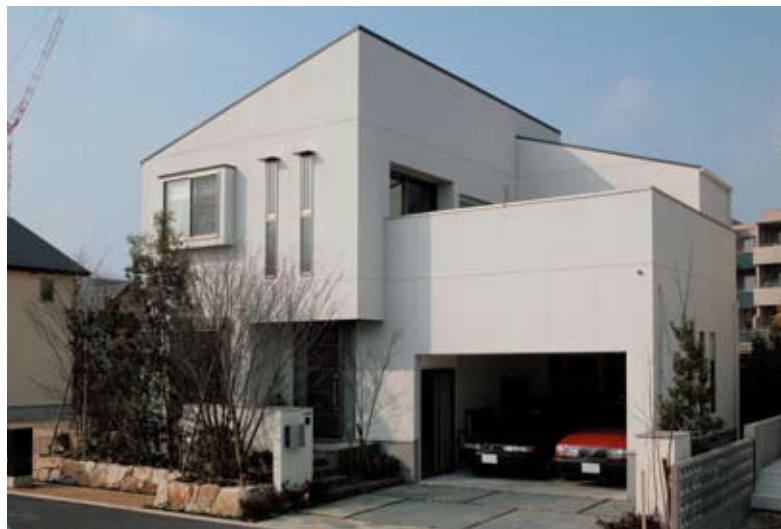
2台分の車を格納できるビルトインガレージがあるK邸。外の駐車スペースに比べ、シャッターを閉めれば不在がわかり難いのは、住まいの防犯上安心できると考え、依頼されたものだという
