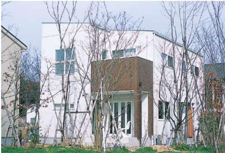
夏には木々が茂り、適度に直射日光を遮ってくれ、避暑地に建つコテージのようなたたずまいのS邸。この場所が気に入り、ぜひここに建てたいと希望されたという
