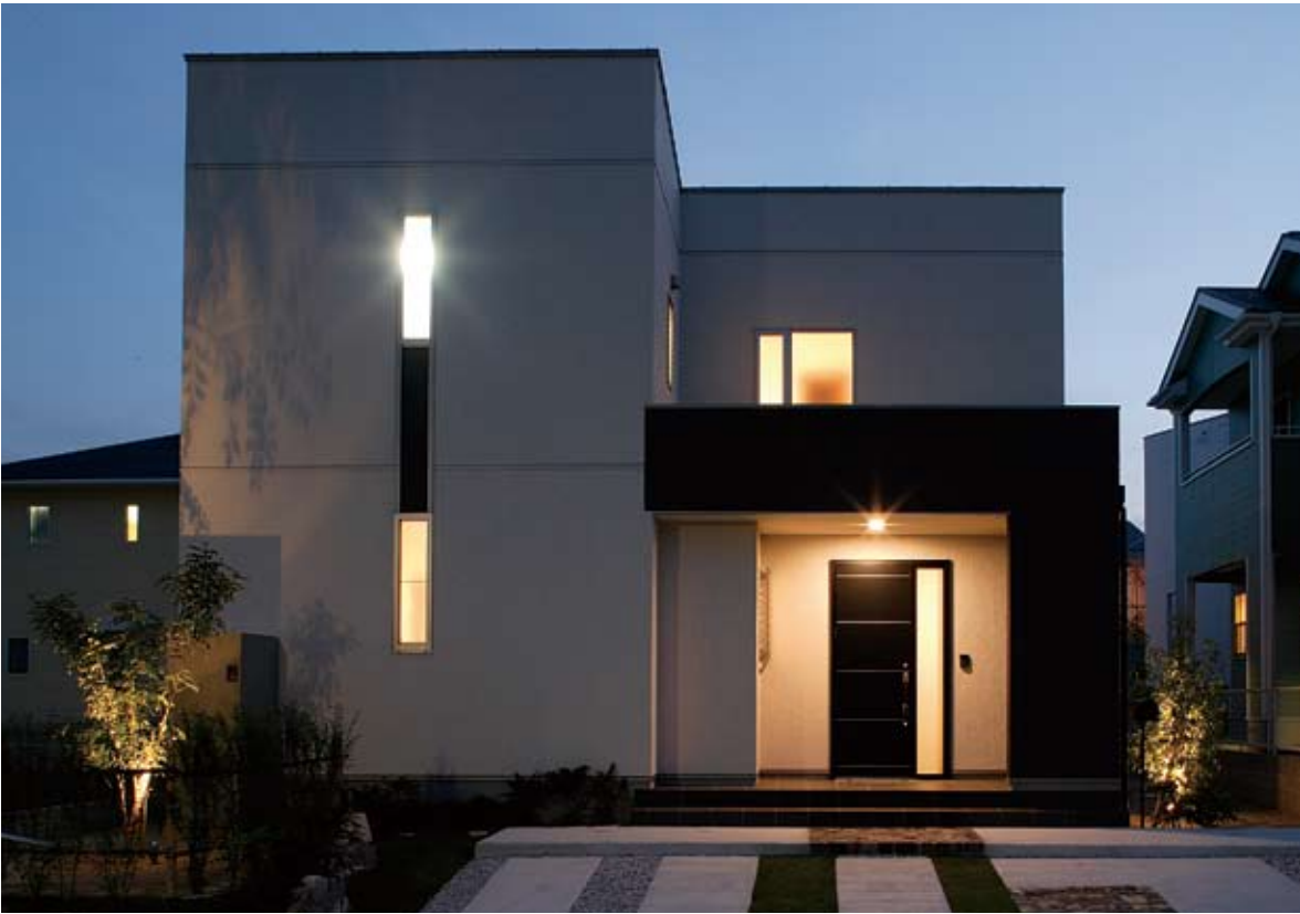
アクセントとなっている縦のスリット窓からの光が印象的な外観デザイン。落ち着いたあるモノトーンの外壁材を巧みに使い分け、つくりあげたシンプルなフォルムは、(株)アースティックが最も得意とするスタイル (右ページ写真はすべて施工例)
