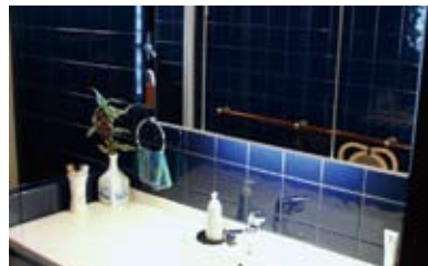
水まわりはすべてタイル仕上げのK邸。2階サニタリーは深いブルーのタイル仕上げられている
