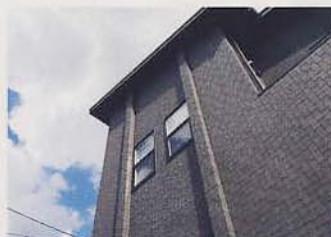
2種類のタイルサイディングを使った外壁は、縦のラインを強調したデザインがアクセント
