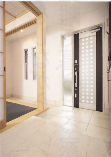
玄関脇に土間を設け、直接和室に上がることができるつくり。ホールの床材は大理石調のタイルを採用
